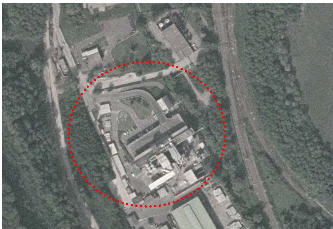
Figura 2: vista aerea dell'impianto
