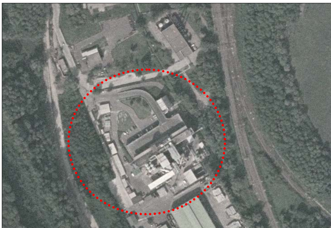
Figura 2: vista aerea dell'impianto
