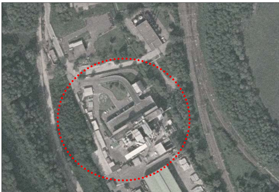
Figura 2: vista aerea dell'impianto
